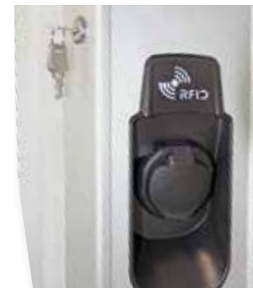
Ladesteckdose Typ 2 mit RFID-Reader
